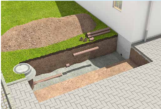
Erneuerung in offener Bauweise
